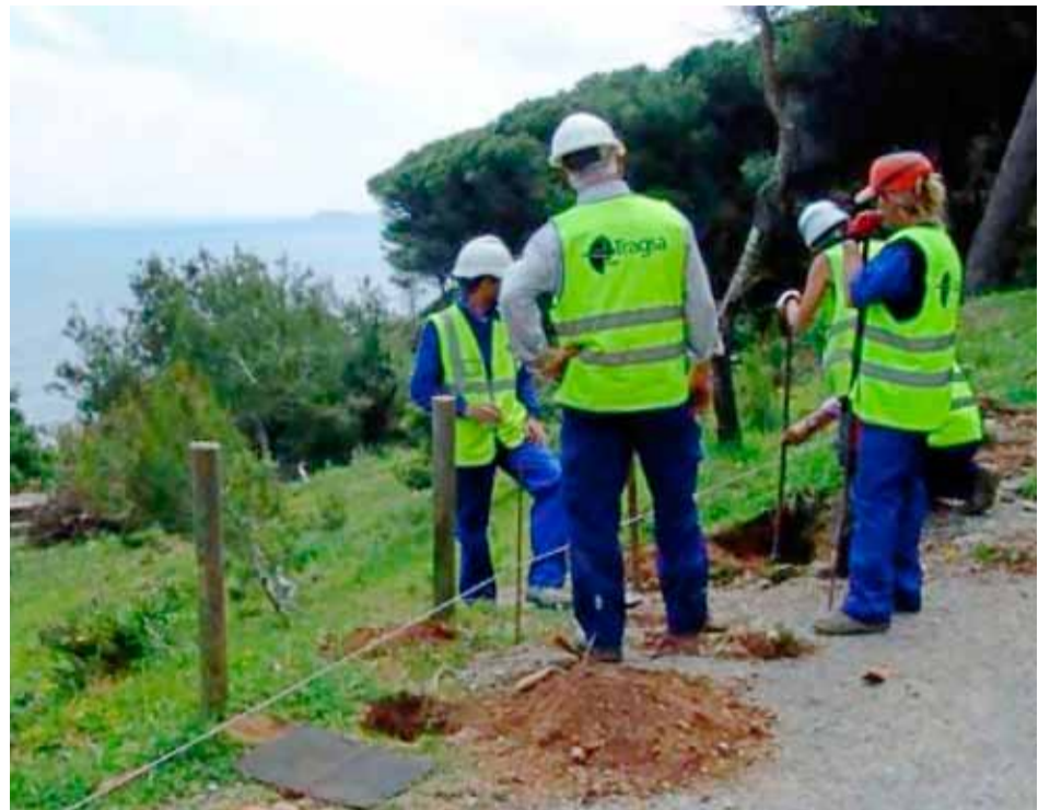
Trabajadores de Tragsa realizando obras en el medio rural.
